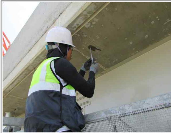
상부구조 탄산화깊이 측정
