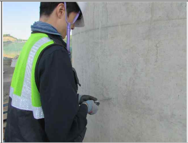
하부구조 탄산화깊이 측정
