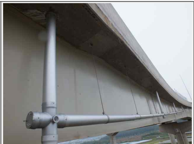
내 용 영천JCT Ramp-B교 배수관
