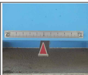
P2 교량받침 이동량 측정
