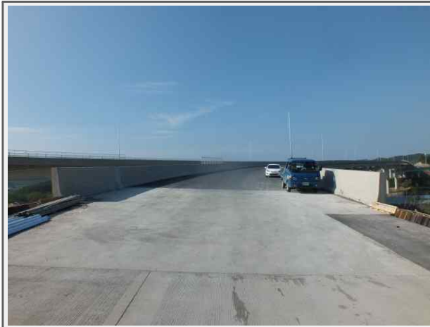
내 용 영천JCT Ramp-B교 상부
