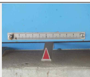
P1 교량받침 이동량 측정
