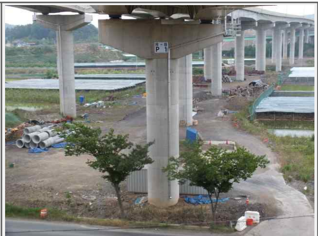
내 용 영천JCT Ramp-B교 교각
