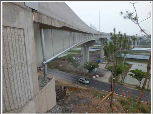
내 용 영천JCT Ramp-B교 측면
