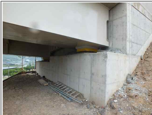
내 용 영천JCT Ramp-B교 교대
