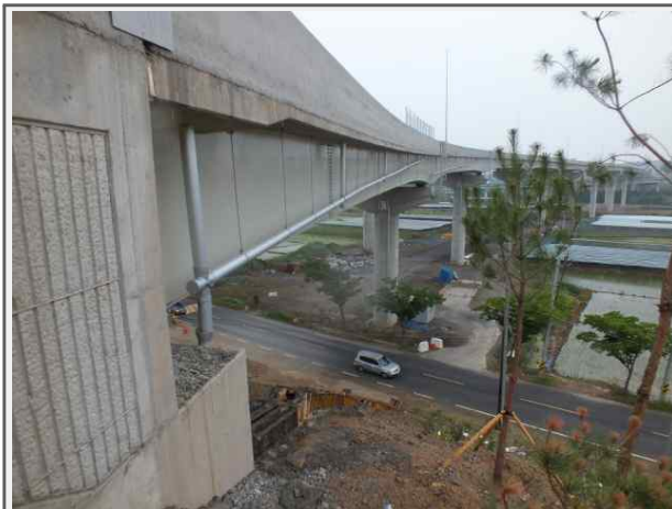
내 용 영천JCT Ramp-B교 거더
