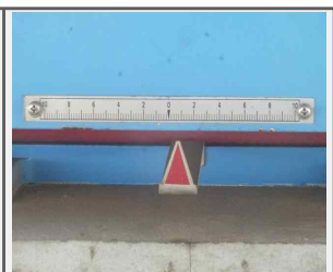
P3 교량받침 이동량 측정
